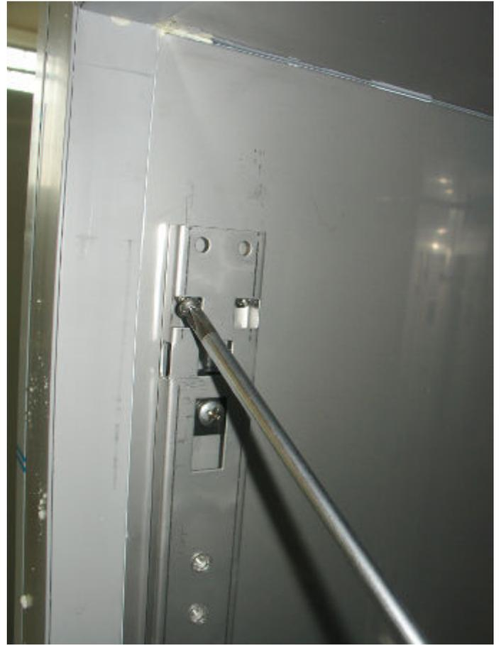
6. Mit je 2 selbstfestziehende Schrauben oben und unten anschrauben
