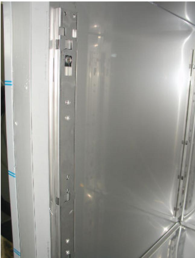
3. Die vorderen Leisten (diese haben inserts) mit den doppelten Löchern nach oben einhängen.
